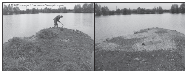
Le chantier pour la sterne, avant et après © Samuel Maas
