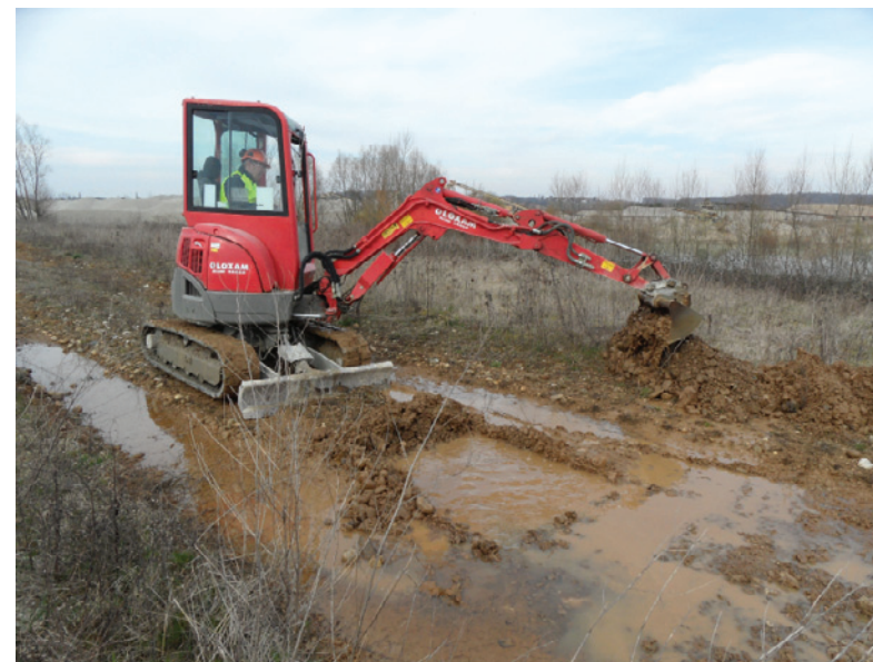
Travaux de creusement de mare à Desnes (39) © Cyrielle Bannwarth
