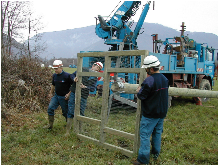
Installation de la 2 ème plate-forme à Cigogne sur la commune de Vulbens
