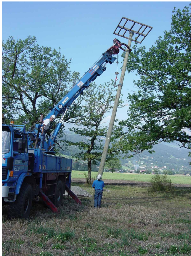
Installation de la 1 ère plate-forme à Cigogne sur la Plaine de Passy
