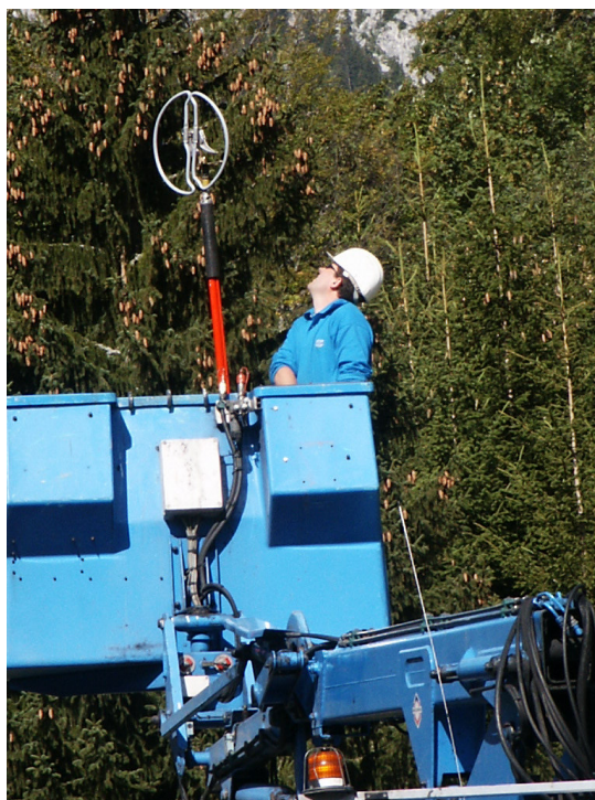
Pose de spirales sur une ligne du Reposoir
