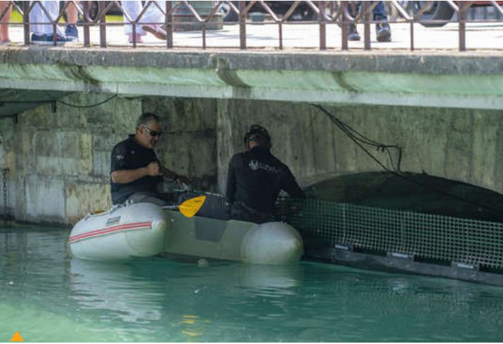
Mise en place de la drome © Ville d'Annecy
