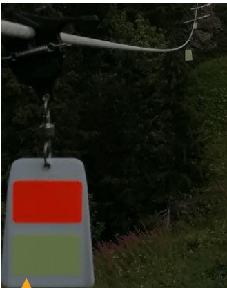
Trois techniques de neutralisation des risques : à gauche, une pince firefly - au centre, des tiges verticales dissuadent l'oiseau de se poser - à droite, les conducteurs sous tensions sont isolés par une gaine plastique. © Enedis, LPO74
