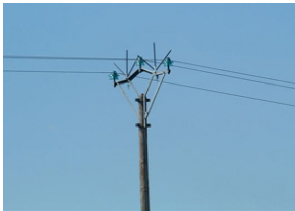
Trois techniques de neutralisation des risques : à gauche, une pince firefly - au centre, des tiges verticales dissuadent l'oiseau de se poser - à droite, les conducteurs sous tensions sont isolés par une gaine plastique. © Enedis, LPO74
