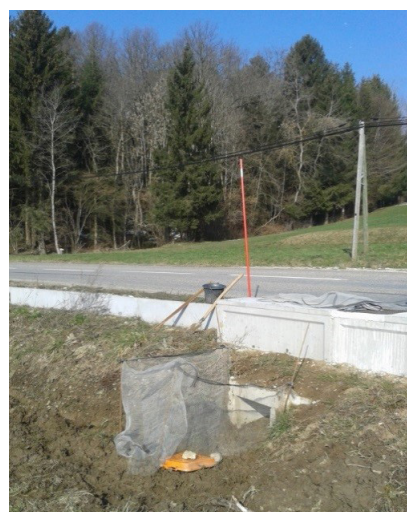
▲ Bac pour récupérer les amphibiens à la sortie du passage à petite faune © Mathilde Gely
