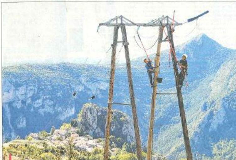
Au-dessus de Rougon, les techniciens spécialisés ont installé des balises sur des lignes sous tension.
