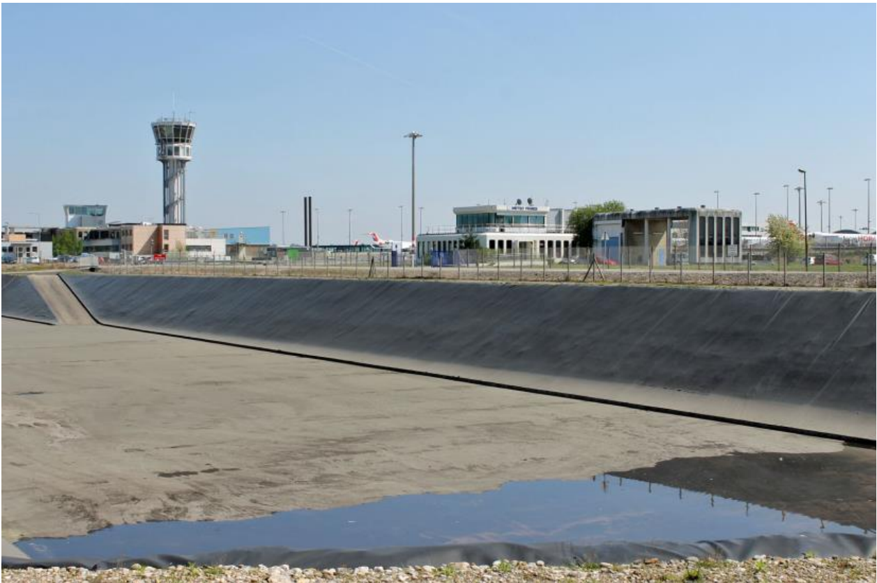
Aéroport de Saint-Exupéry, bassin de rétention d'eau voisin du bassin d'orage n°2, D. TISSIER, Colombier-Saugnieu, avril 2015. En arrière-plan, la tour de contrôle de l'aéroport et la station de Météo-France.
