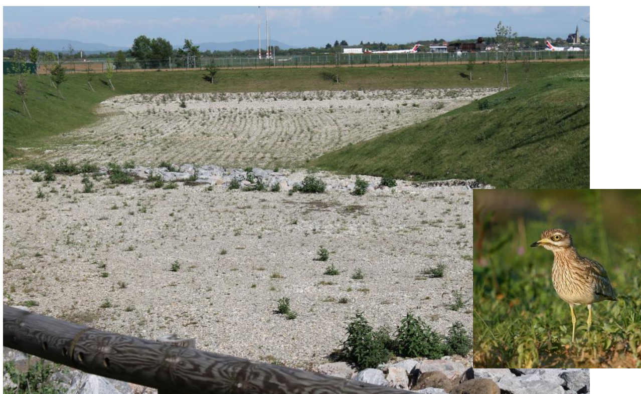
Aéroport de Saint-Exupéry, bassin d'orage n°1, D. TISSIER, Colombier-Saugnieu, avril 2015 : plus petit et n'abritant qu'un ou deux oiseaux, mais plus facile à photographier, le bassin n°1 permet de mieux voir la structure du sol comparable à celle du bassin n°2 dont les talus sont toutefois moins herbeux.
