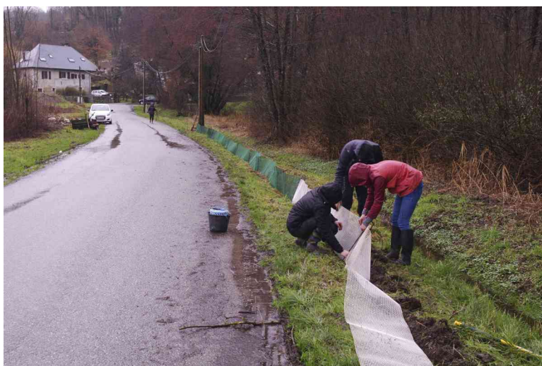
Figure 5 : Installation d'une barrière à amphibiens, à Saint Girod.
