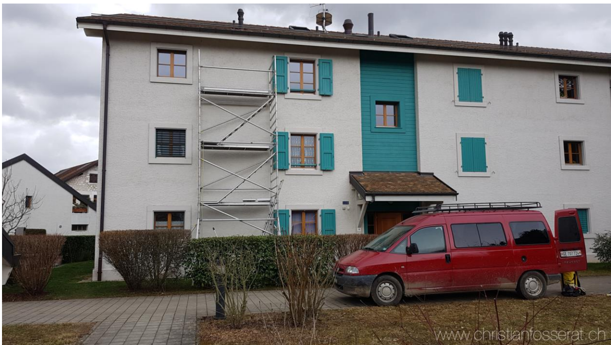
Figure 1 : La pose des nids et des planchettes à Russin a nécessité la mise en place d'un échafaudage.
