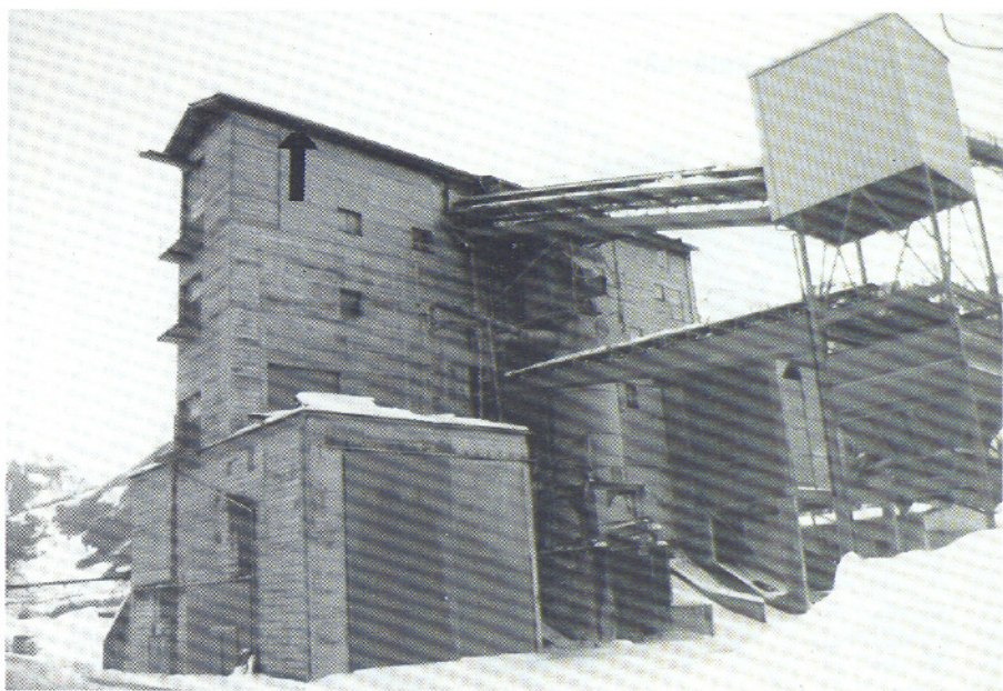
Grandvillard. Installation de tri de gravier, site occupé en 1987. Aquilino Cabezas.
