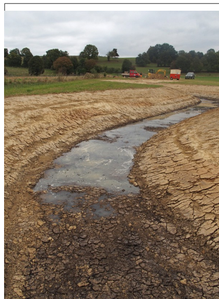
Fig. 8 : Le 7.10.16, "miracle", l'eau arrive dans le nouveau lit (photo. M. Rebetez).
