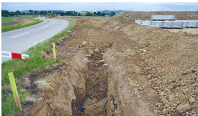
Fig. 9. La construction des crapauducs a enfin commencé, Damphreux, 8.6.2020.
