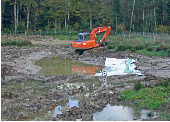
Fig. 7. Travaux d'étanchéification, Lugnez, 27.10.22
