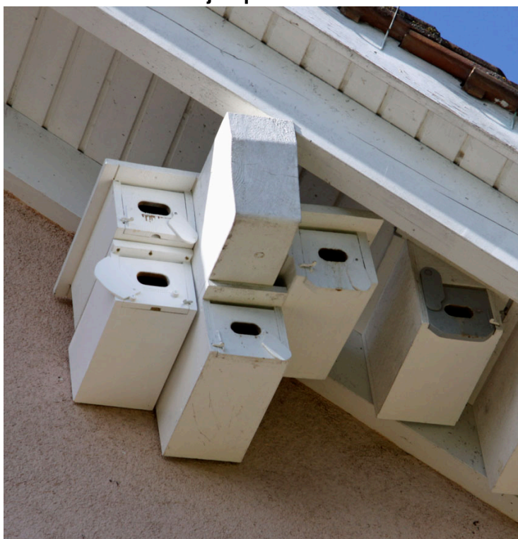
Zone N10 à N14 jusqu'en 2022 : vue frontale
