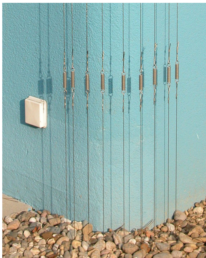
Fils d'acier sur les parties de la façade menacées par les pics, et détails des éléments tendeurs. © Verena Döbelin
